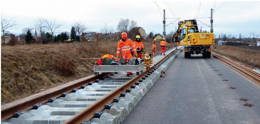
**Abb. 3:** Bei der Erstellung des ersten Schienengleises ermöglichte noch die straßengebundene Logistik eine gute Verlegeleistung.
