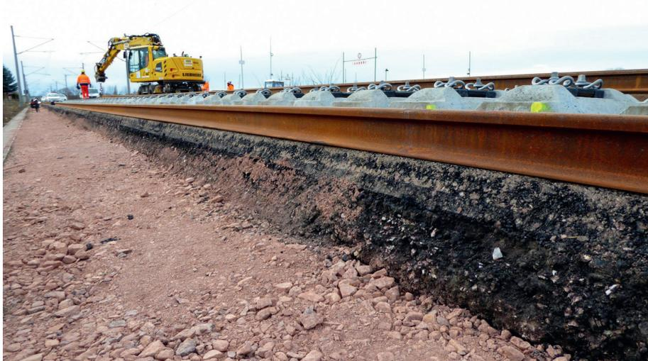
**Abb. 2:** Die Verantwortlichen beschlossen frühzeitig, die bestehenden und unbeschädigten unteren Asphalttragschichten nicht abzutragen. So konnten sie einen Neubau verhindern und Zeit und Kosten einsparen.
