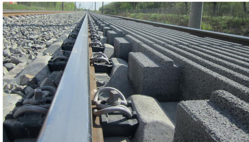
**Abb. 6:** Das Befestigungssystem 300-1 überzeugte beim Einbau mit seiner vertikalen Regulierungsmöglichkeit im Stützpunktsystem.
