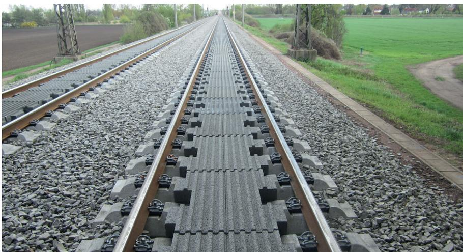
**Abb. 4:** Nur mit einem Asphalt basierten FF-System war es überhaupt möglich, das Projekt in der witterungsunsicheren Winterzeit erfolgreich umzusetzen.
