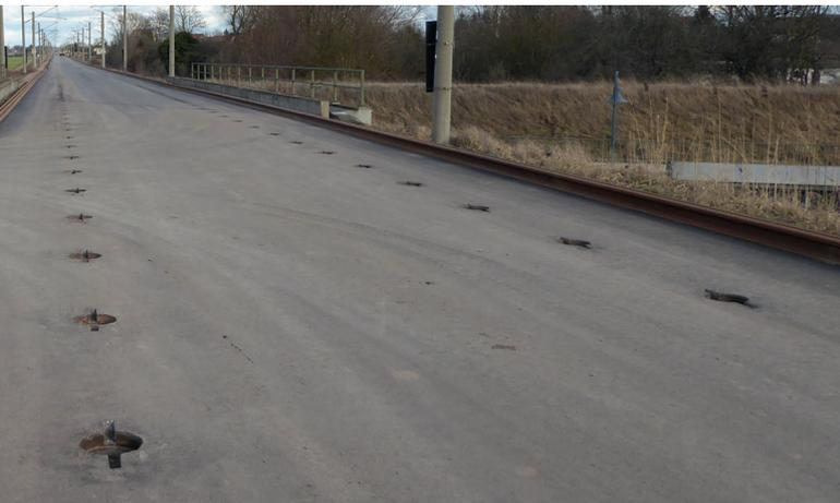
**Abb. 5:** Festes Fundament: Die fertige Asphaltdecke mit den Dübellochern für die Getrac-Schwellen
