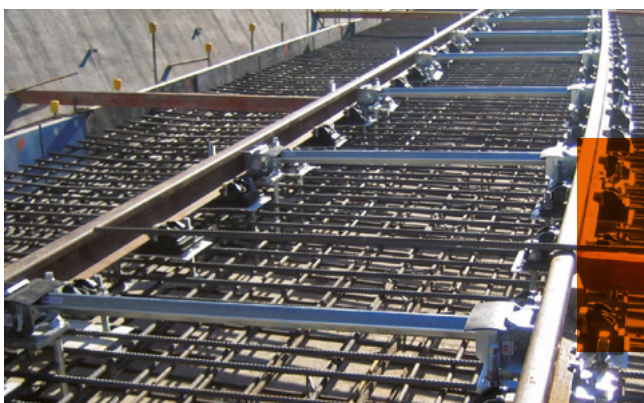
Richten eines Gleisrostes mit Direktstützpunkten (Adelaide/Australien)
